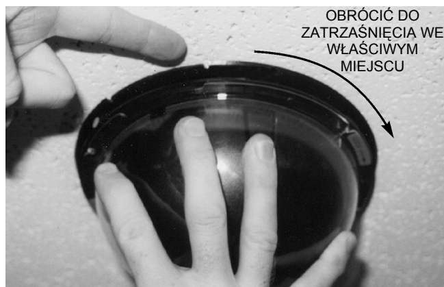
Fot. 2G. Montaż kopolki
